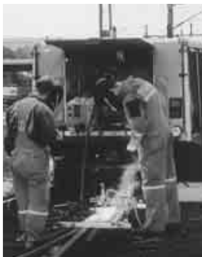
Mekaniserad svetsning: Railtrac BV/OK Tubrodur 15.43.
