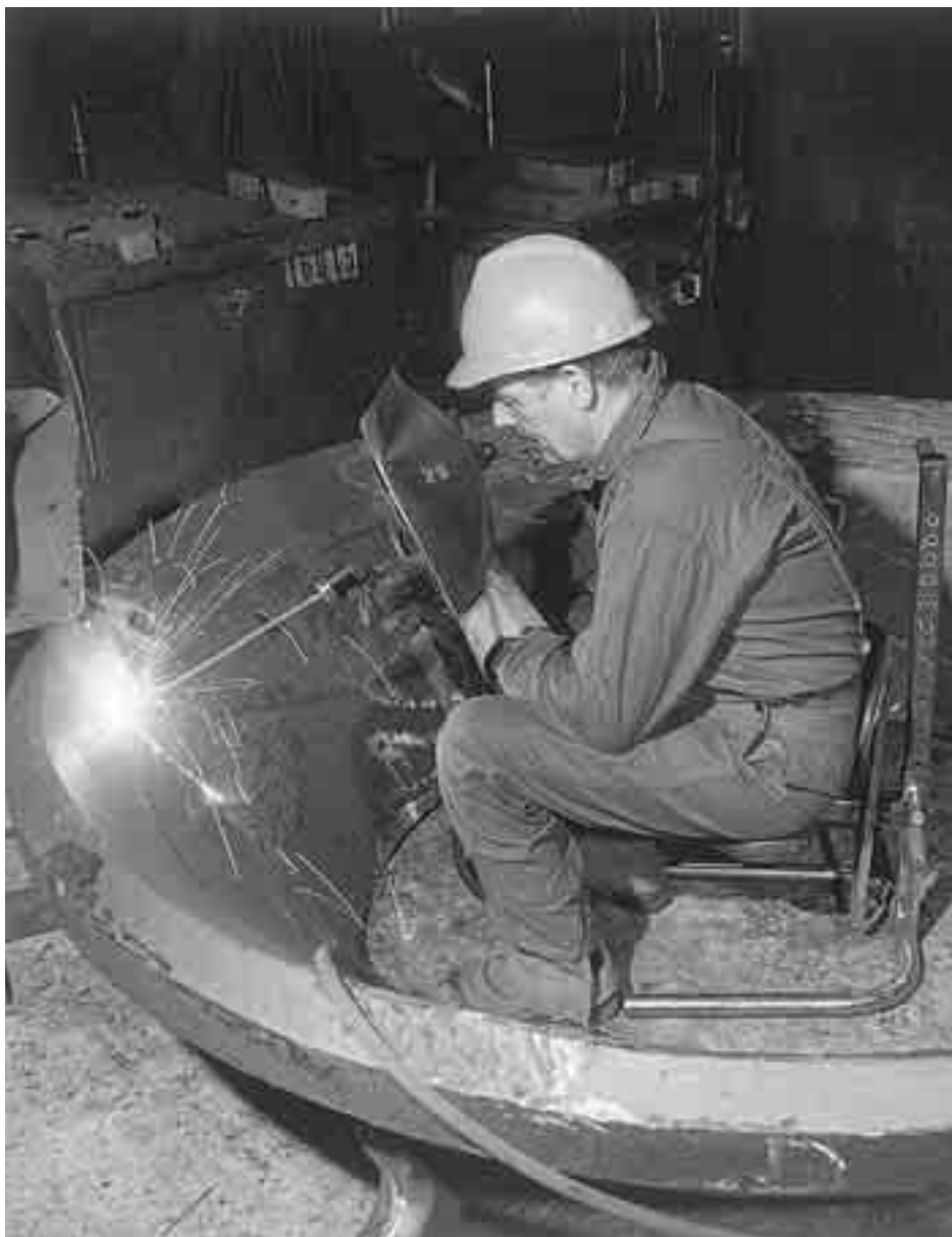
Reparation av del till krossverk av 14% Mn-stål med användning av OK 86.08
