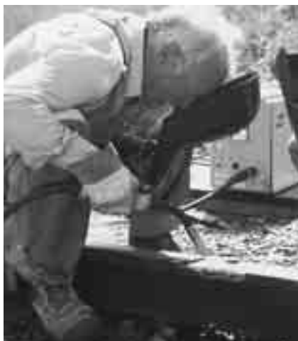
Reparation av slirspår: OK Tubrodur 15.43.
