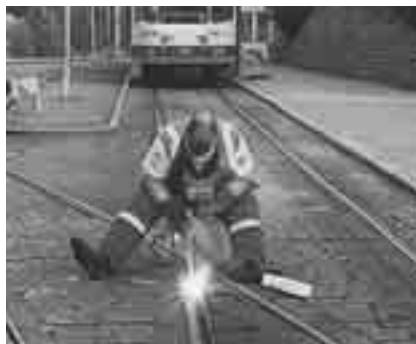
Reparation av spårvagnsräl: OK 67.52.
