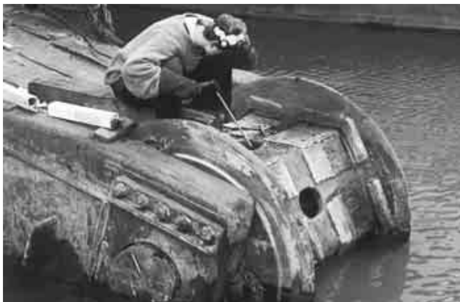
Hårdsvetsning av trumma med OK 84.84. Fyllnadsvetsning med OK 83.28.
